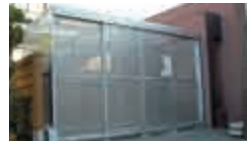
▼新設ゴミステーション
